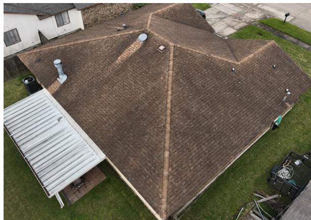
Right Roof Elevation (Oblique 45°)
